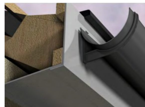
Bondoeau ac estyll yr Uned Gofal Plant - Alwminiwm - Gwyn (RAL 9010), Nwyddau dŵr glaw Alwminiwm (RAL 7016)
