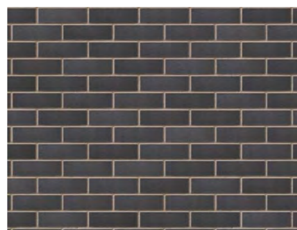
Gwaith brics o dan y cwrs gwrth-damp – brics peiranyddol glas Swydd Stafford wedi'u gosod ar ffurf uniad brics ar ei hyd hanner-lap
