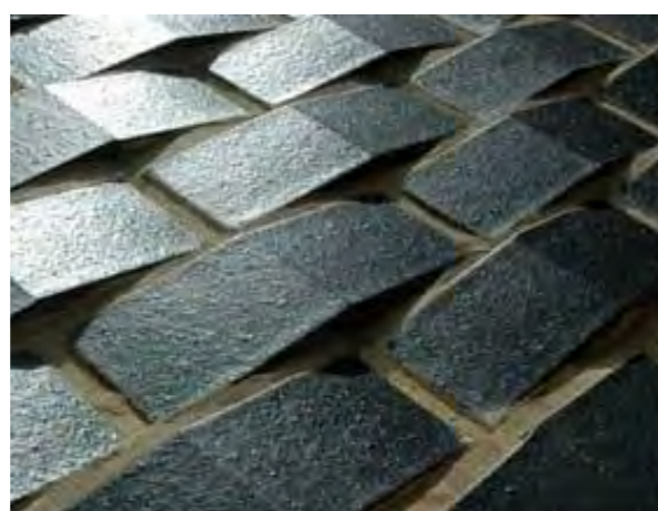
Gwaith brics nodwedd – Brics dannedd llif wmbra Istock wedi'u gosod ar ffurf uniad brics ar ei hyd hanner-lap – Glas Llechi Swydd Stafford llyfn
